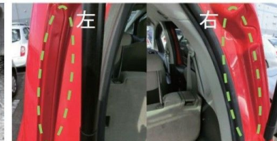
画像④左右で見比べてみる(右:再溶接、左:新車時溶接)
